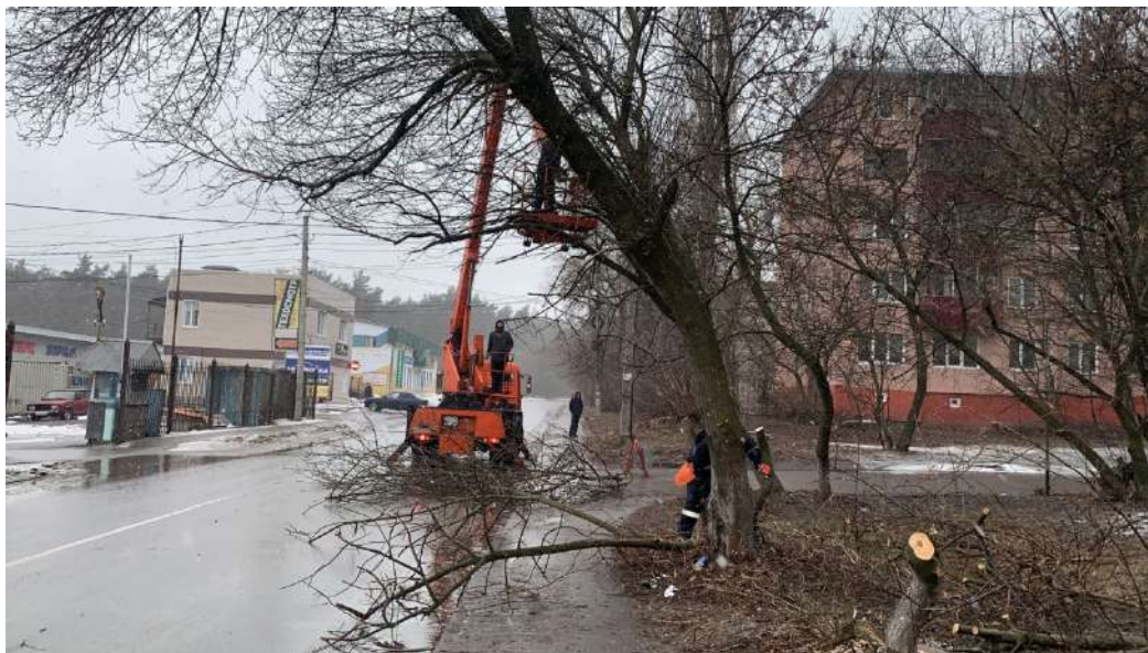
Рис. 12.11. Снос аварийных деревьев
