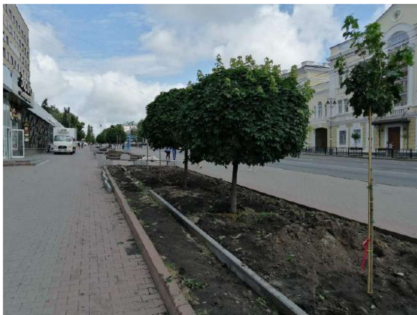
Рис. 12.7. Работы по посадке деревьев клена шаровидного по ул. Ленина
