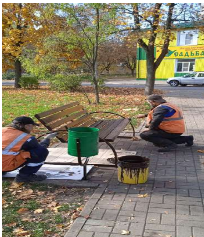
Рис. 12.3. работы по ремонту лавок
